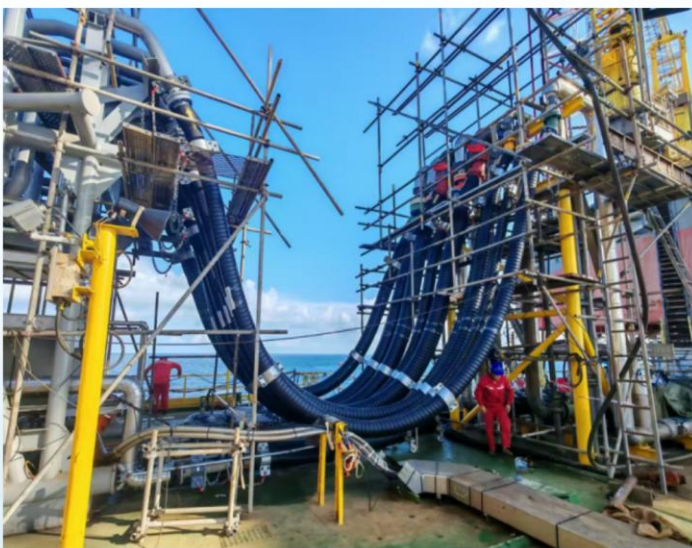
图为涠洲项目
