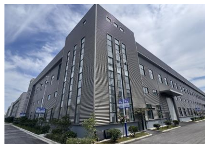
一号厂房竣工
