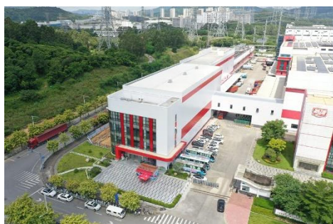
广垦乳业智慧物流中心项目
