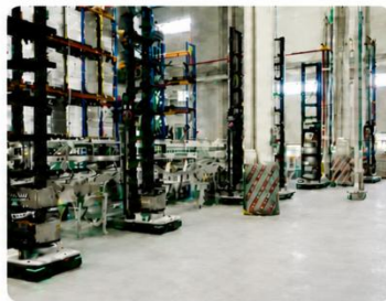
境外综合食品零售集团项目现场
