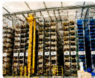
国内大型工业装备制造企业项目现场
