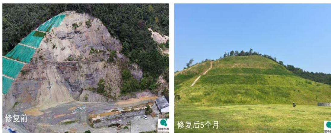
江西上饶某山体坡面修复前后实景图
