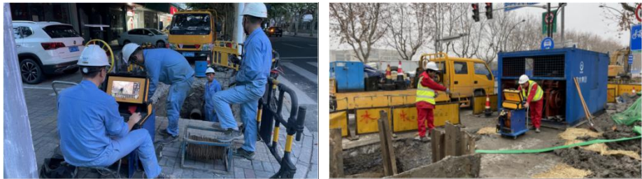
图 15 管道检测工程案例
