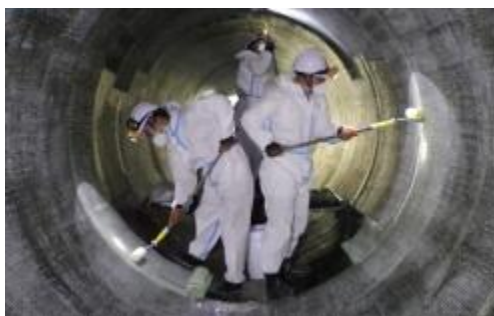
图 19 某地管道非开挖修复项目
