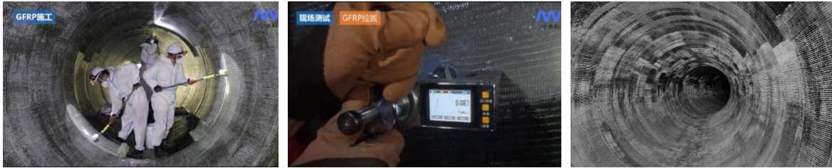
图 17 DN2400 污水管道非开挖修复案例
