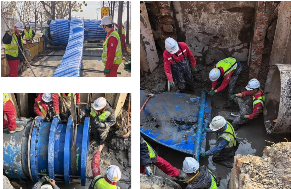
图 16 DN1200 供水管道内衬修复案例
