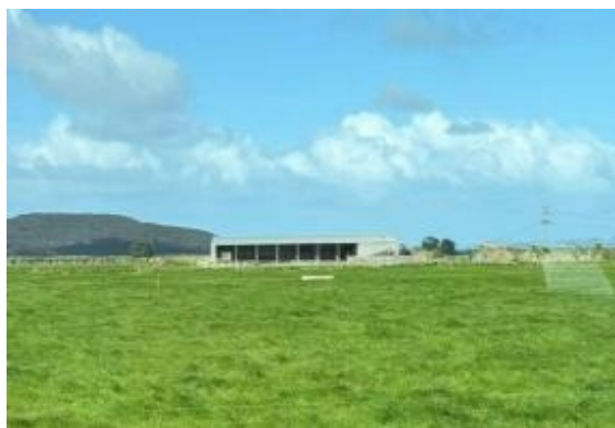
新西兰 Glorit 170MW 光伏电站 EPC 项目
