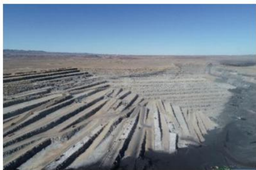
图五 新疆别斯库都克露天煤矿矿山一体化总承包项目
