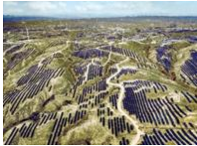
宁夏中卫光伏发电 EPC 工程
