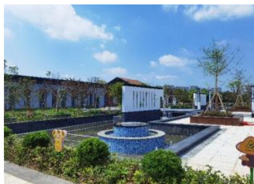
南昌市新建城地下生态水厂（2 万吨/天）
