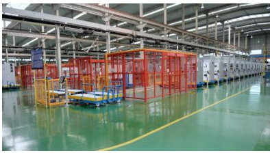
开关柜装配 MES 系统
