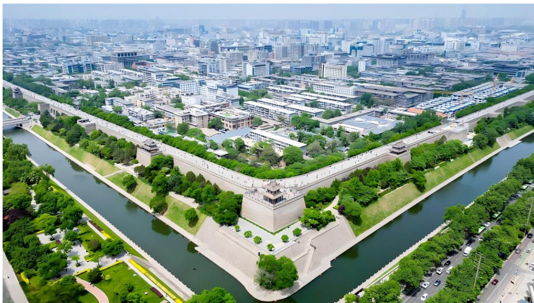
西安市明城墙区域内排水设施综合治理工程一标段项目
