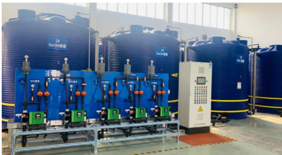
杭州临平自来水厂（2021）
