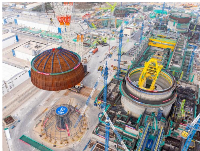
福建漳州 3 号机组核岛穹顶吊装
