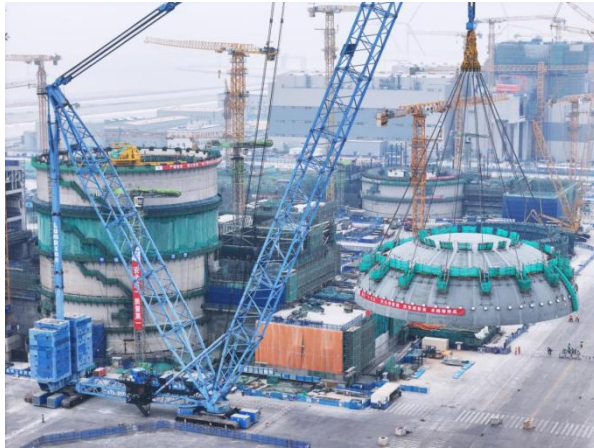
辽宁徐大堡 1 号机组核岛穹顶吊装
